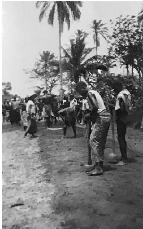
FIGURE 6.6. Road construction in Dahomey, 1933. Source: Archives Nationales d'Outre-Mer, Aix-en-Provence, France, 1TP/34/8, "Rapport de mission effectuée sur les routes de l'A.O.F. du 26 avril au 12 juillet 1933."
